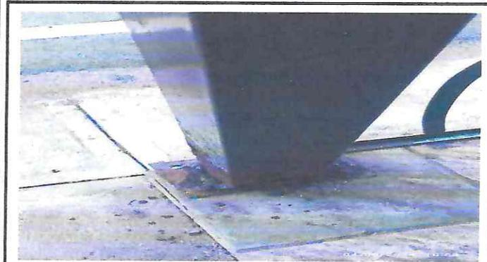
Sustitución de soporte a estructura de metal
